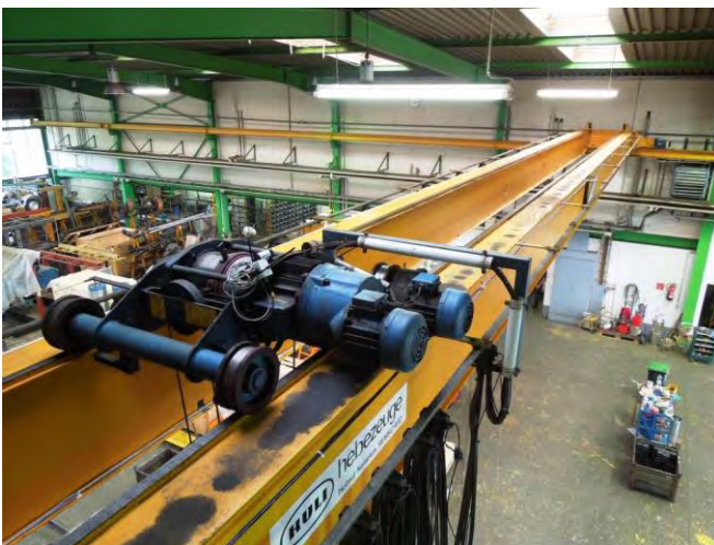
Abbildung 22: Messobjekt Zweiträgerkran ZK 3.2 t * 18,95 m
